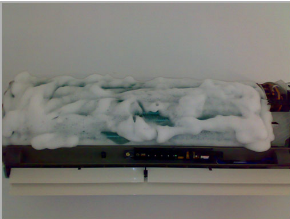
Parownik w trakcie czyszczenia chemią:
