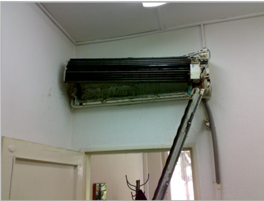
Przykład bardzo mocno zabrudzonego wentylatora w parowniku:
